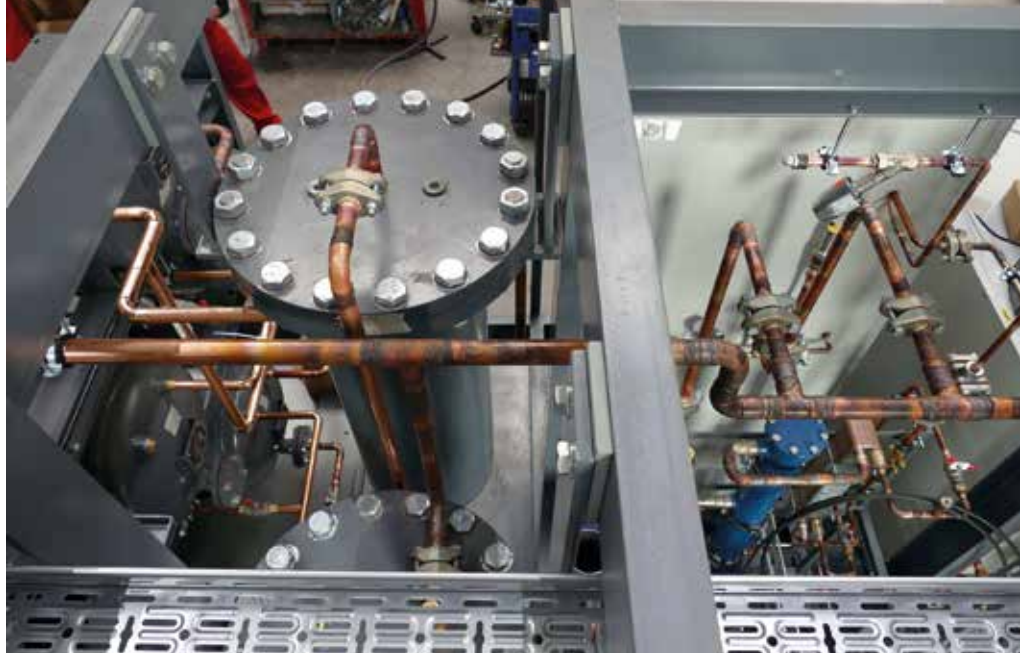
Die Kältemittel-Absauganlage ist TÜV-zertifiziert, TA Luft-konform und entspricht allen relevanten Vorschriften wie dem AwSV-Gutachten („Verordnung über Anlagen zum Umgang mit wassergefährdeten Stoffen“) sowie der ATEX-Richtlinie 2014/34/EU für Anlagen in explosionsgefährdeten Bereichen.
