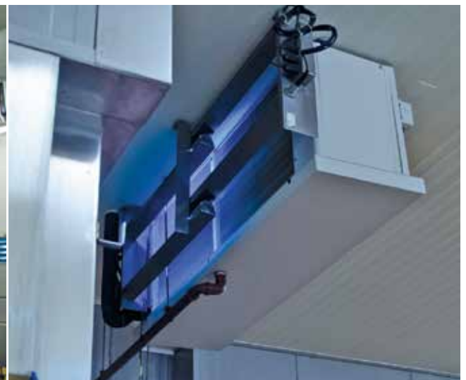
Um eine rundum hygienische Produktionsatmosphäre sicherzustellen, setzt Berger Schinken UV-C-Entkeimungssysteme zur Luftreinigung ein.
