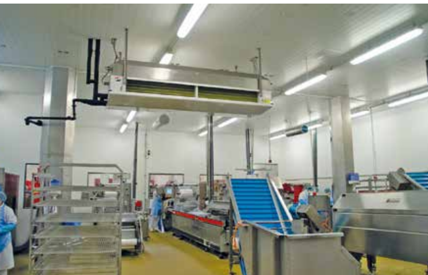
Um eine rundum hygienische Produktionsatmosphäre sicherzustellen, setzt Berger Schinken UV-C-Entkeimungssysteme zur Luftreinigung ein.
