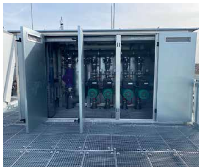
Kernelemente der Pumpstation sind zwei parallel verbaute elektronisch geregelte Hocheffizienz-Einzelpumpen von Wilo. Weitere Elemente sind zwei redundante Schmutzfänger, Absperrventile und ein Ausdehnungsgefäß. Alle Komponenten sind auf einem Gestell installiert.
