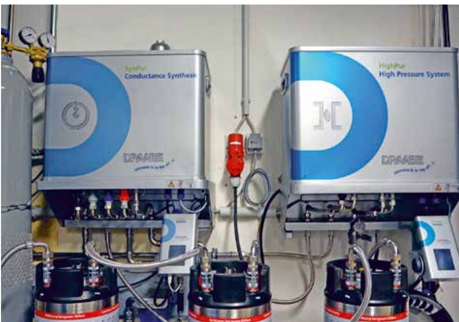
Mehrstufige Wasseraufbereitung in mobilen Kleincontainern.
